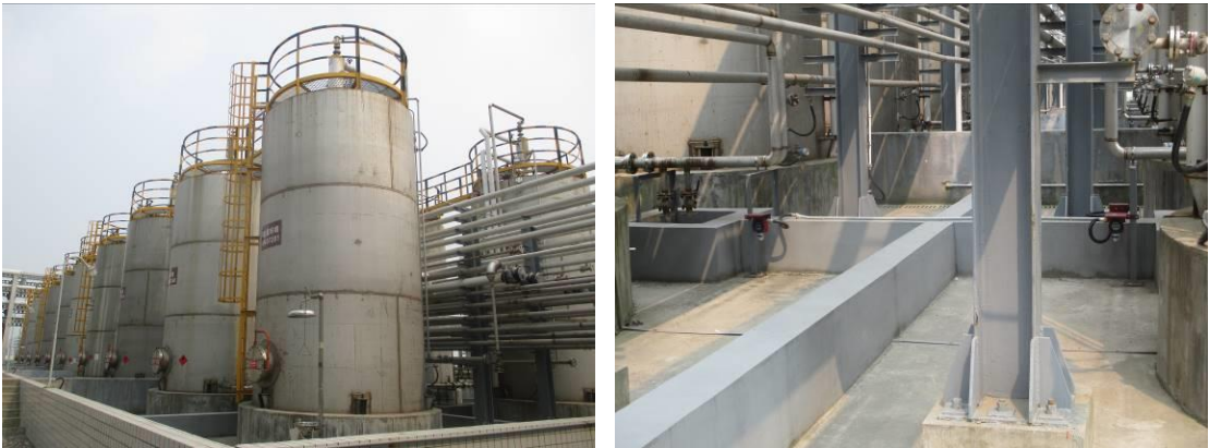
厂区罐区围堰及罐区内防腐、防泄漏措施
